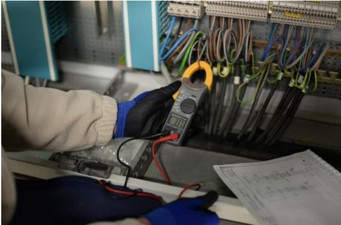
*Contrôle d'intensité des principaux moteurs (CTA)
