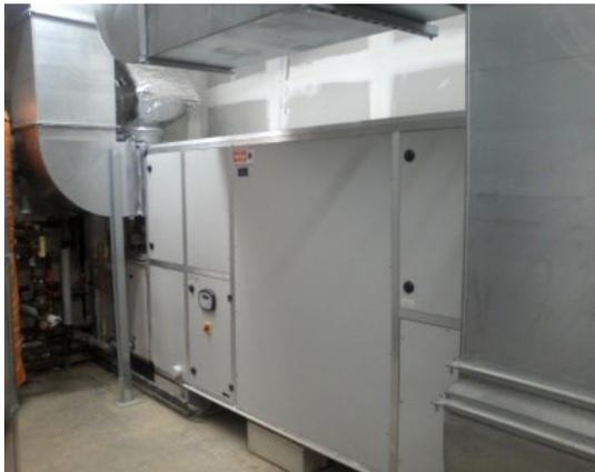
Le chauffage des vestiaires est assuré par une centrale de traitement d'air à double flux fonctionnant en 100% air neuf. La fonction chauffage est assurée par une batterie à eau chaude alimentée par le réseau de récupération de chaleur. Cet équipement est raccordé à la GTC en lecture seule des régimes de fonctionnement.
