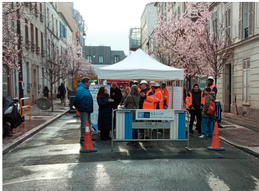
Petit-déjeuner sur le chantier Sadi Carnot à Montrouge
