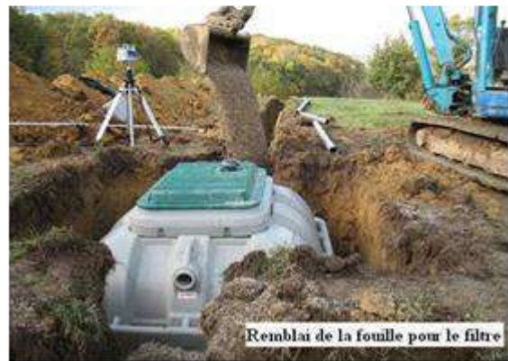
Photos : Autres exemple d'installation d'ANC avant et après remblai
