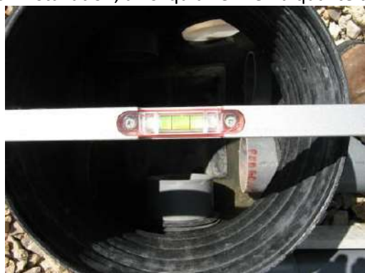
Photos : Vérification de la collecte des effluents et mesure de l'horizontalité sur un regard de visite
