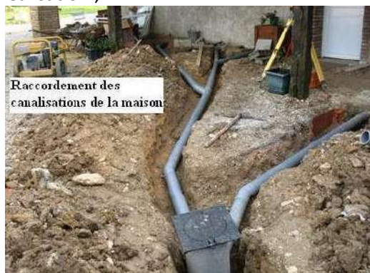
Photos : Vérification de la collecte des effluents et mesure de l'horizontalité sur un regard de visite
